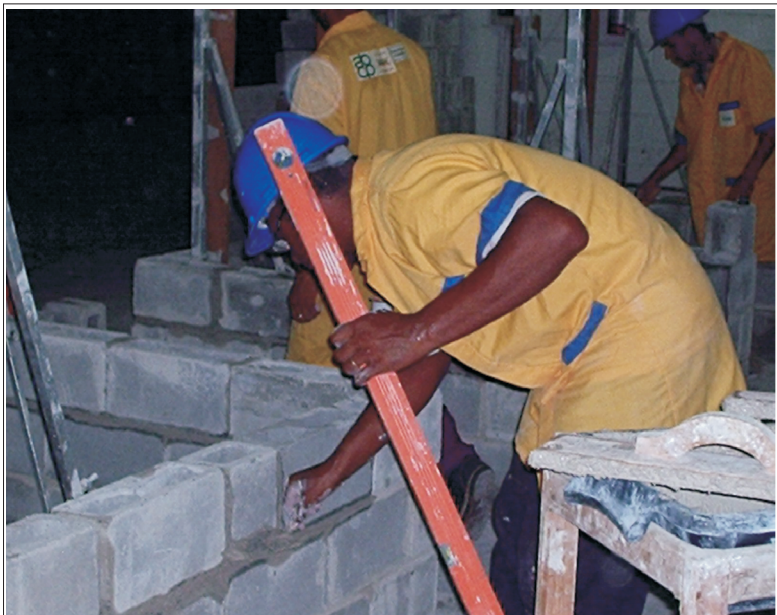
Treinamento "Acentamento Bloco Estrutural".
