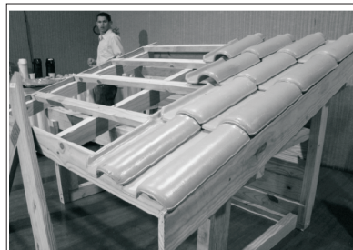
Telhado com Madeiras de Reflorestamento
